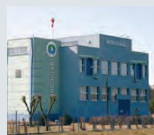
Miejskie Wodociągi i Oczyszczalnia, Grudziądz, Polska
