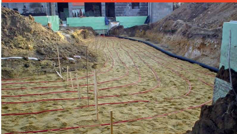
Rys. A.4.1-2 Źródło ciepła – kolektor ziemny poziomy
