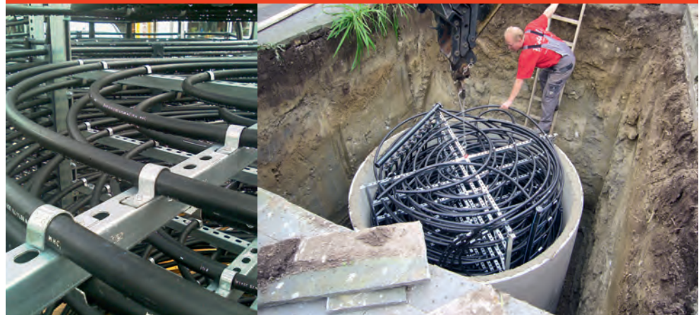
Rys. A.4.7-2 Zasobnik ciepła wykorzystujący przemianę fazową
