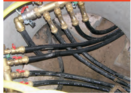
Rys. A.4.1-8 Rozdzielacz solanki w sondzie ziemnej
