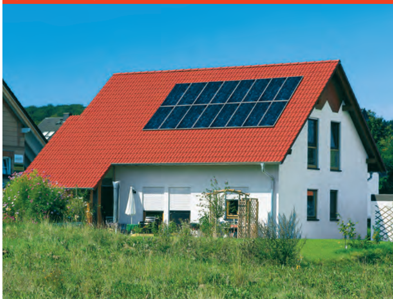
Rys. B.1.4-1 Instalacja fotowoltaiczna
