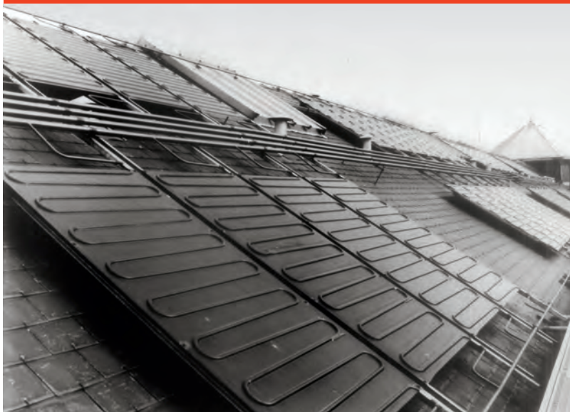
Rys. A.4.6-1 Źródło ciepła – absorbery nieprzeszkłone
