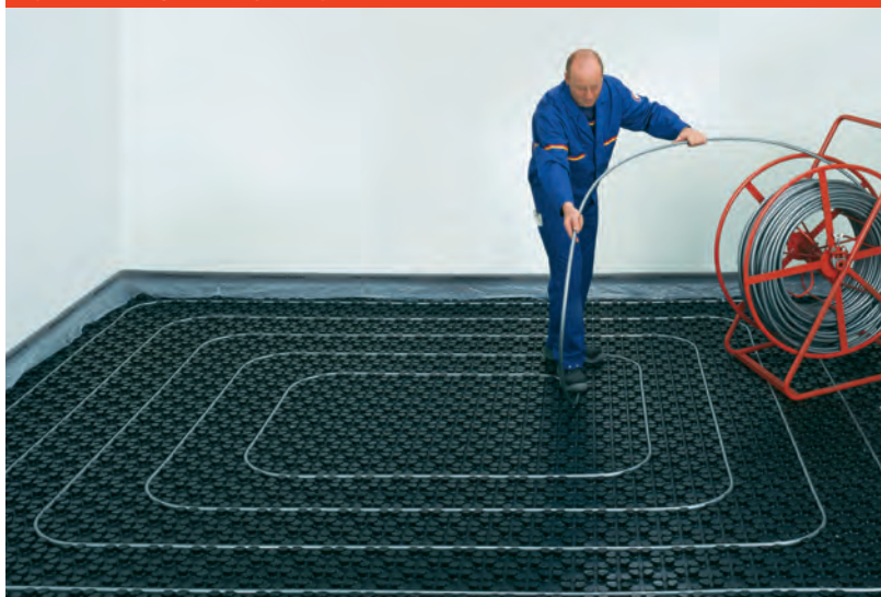
Rys. D.2.2-6 Ogrzewanie płaszczyznowe
