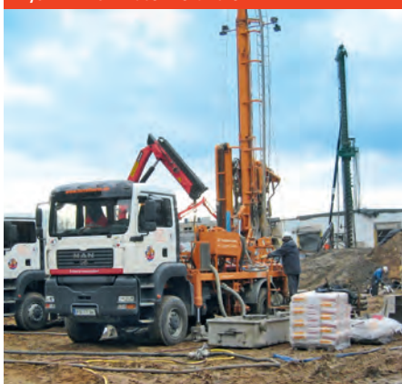
Rys. A.4.1-6 Prace wiertnicze
